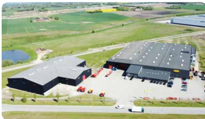
Testhal, pulverlakering, montage og forsendelse "Nimvej"
