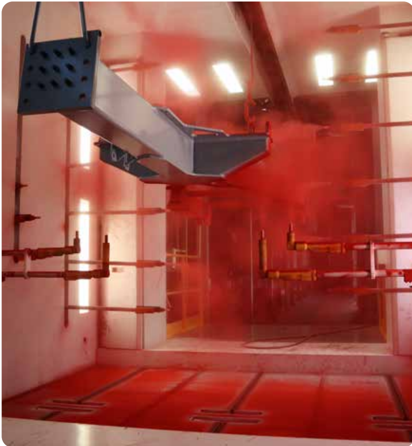
Den afsluttende påføring af den velkendte røde pulverlak oven på grundlakeringen
